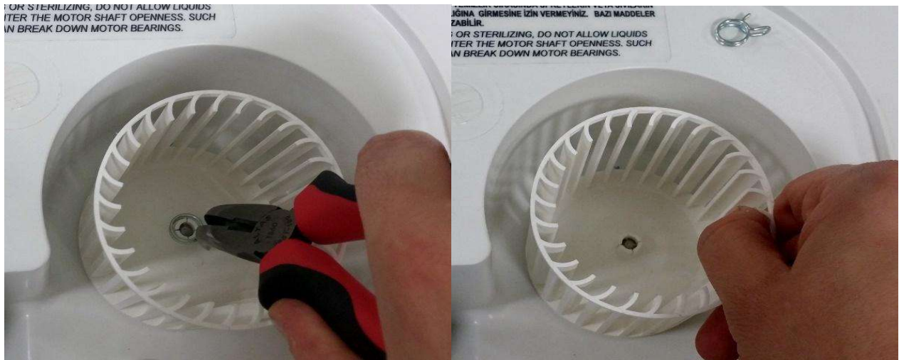
Şekil 51 :Fanın Çıkarılması
